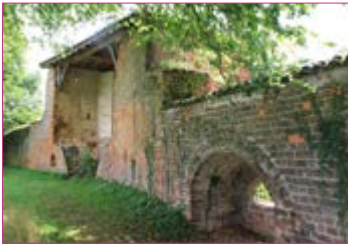
Pans de murs et arches
