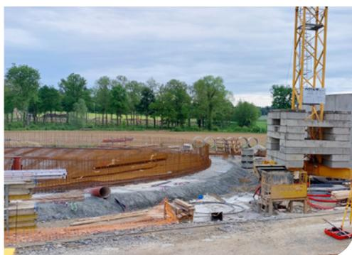
➡ **Nouvelle Station d'Épuration** Les travaux de construction de la nouvelle STEP continuent. Actuellement les ouvrages du bassin d'aération, qui sert au traitement des eaux usées, et du clarificateur, pour la séparation des boues et des eaux claires sont en cours jusqu'à la fin du mois de juin. En parallèle, les équipes travaillent sur les bâtiments administratifs. Le chantier est réalisé par une dizaine de compagnons sur site en ce moment, et doit se terminer en fin d'année 2023.
